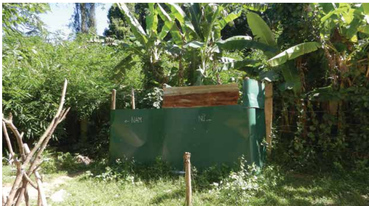
Ảnh 33: Nhà vệ sinh cũ Trường THCS Thanh, huyện Hướng Hoá, tỉnh Quảng Trị
